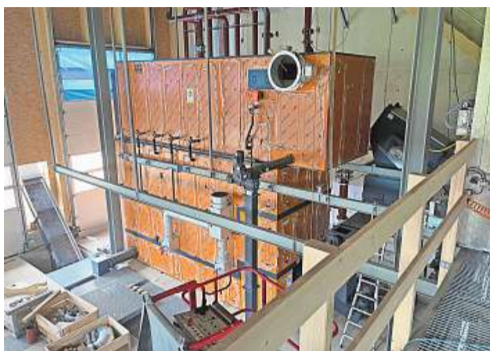
Viele Elemente der Heizanlage stehen schon.
