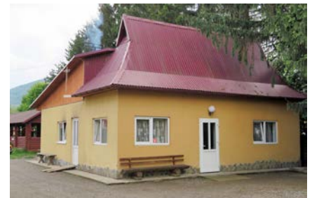
Wärterhaus mit Holzheizung
